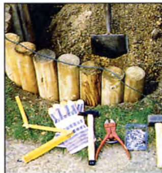
Колышки располагают дугообразно вплотную друг к другу и скрепляют проволокой в пластиковой оболочке. Проволоку фиксируют скобками.
